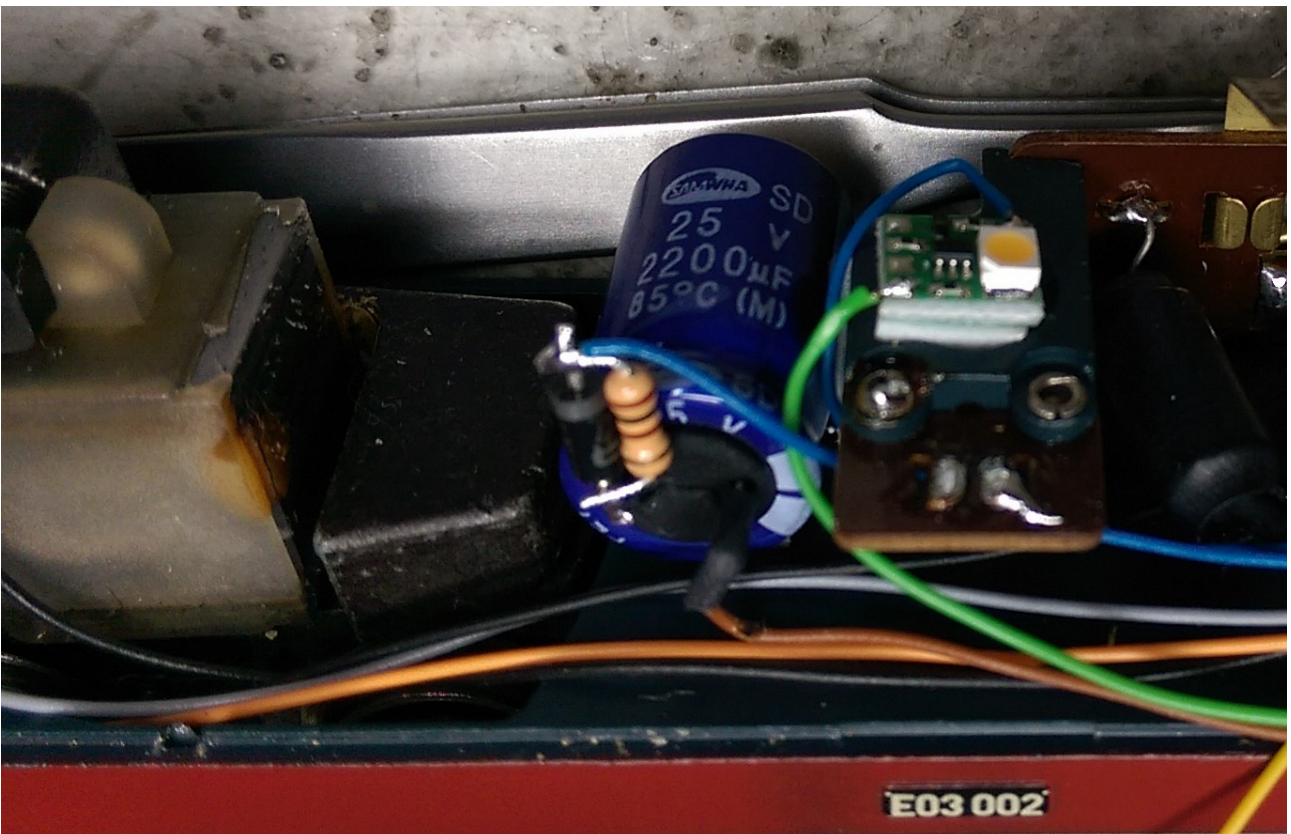
Bild 11: Stützello mit Ladeschaltung, fertig verdrahtet.
